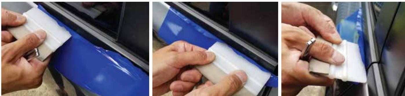
剥がした部分の上からモールの隙間に沿ってスキージーで押し込んでください。
